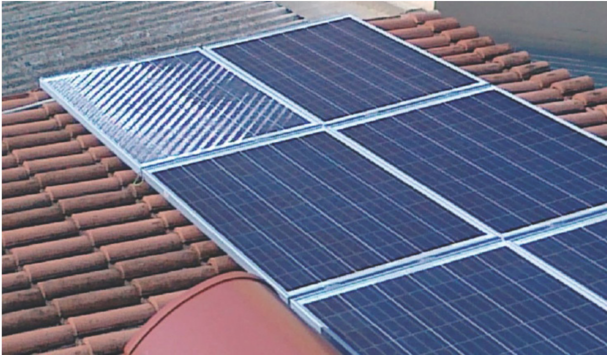
左角 1 枚のみサーファシールド G 未塗布。(反射防止効果)
